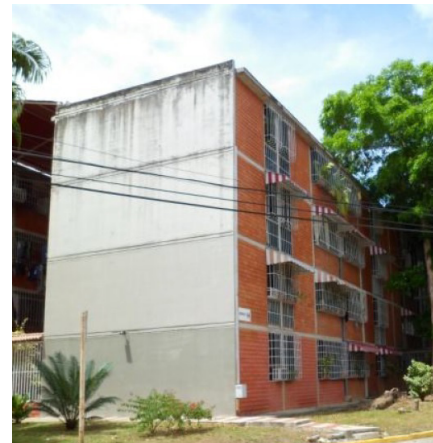
Figura 7. Edificio N° 18: Posee muros de concreto armado de poco espesor en una sola dirección
