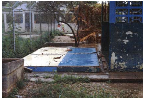
Figura 2.7. Volcamiento de paredes de relleno en el Grupo Escolar Matías Parra Alcalá en Casanay durante el sismo de Cariaco de 1.997 (cortesía FEDE).
