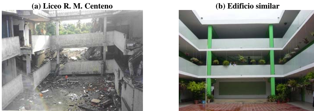
Figura 2.6. Los dos edificios del Liceo R. M. Centeno derrumbados en Cariaco en 1.997 pertenecen al Tipo Cajetón que se encuentran distribuidos en todo el país.
