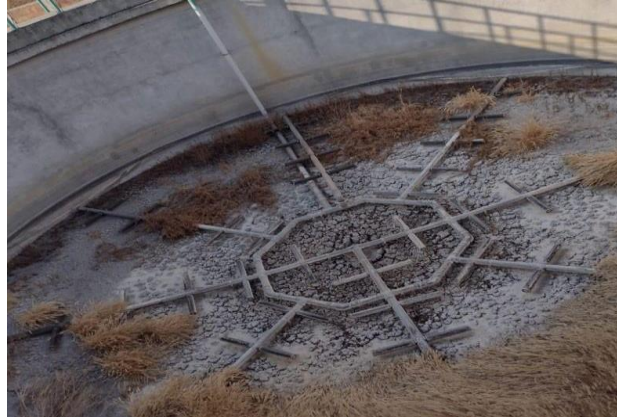
Figura 4. Tanque digestor de lodos. Fuente: Trabajo de campo (2023)
