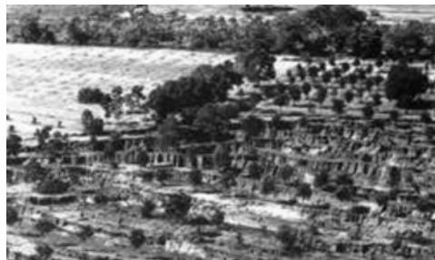
Figura 4. Zona de Güigüe, sur del Lago de Valencia, estado Carabobo, proceso de «lateral spread». Fuente: Colección Steinbruge, U. de Berkeley.
