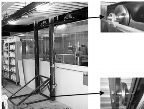
Figura 3. Detalles del montacargas construido para el SASMP.
