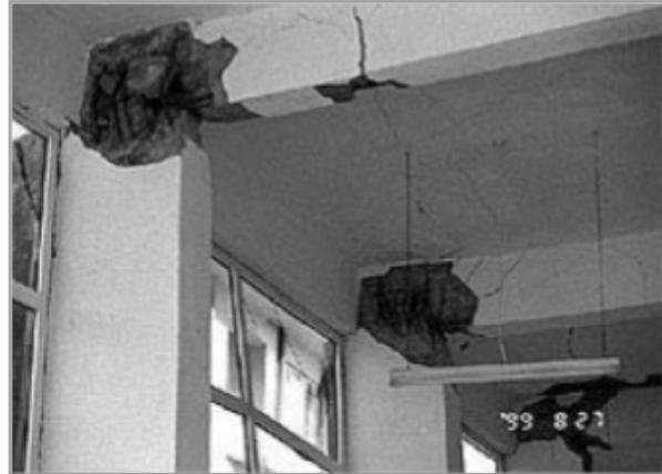
Figura 35. Acero transversal en junta
