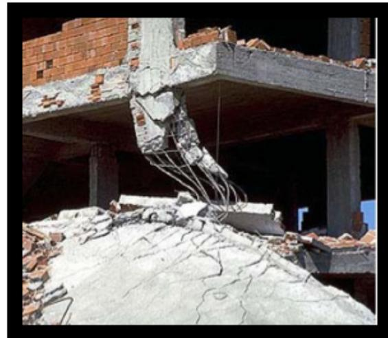
**Figura 42.** Daño severo en columna
