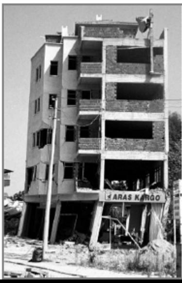
**Figura 24.** Dirección poco resistente a fuerzas laterales debidas a sismos
