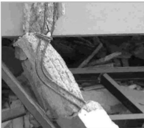
Figura 34. Falta de acero transversal
