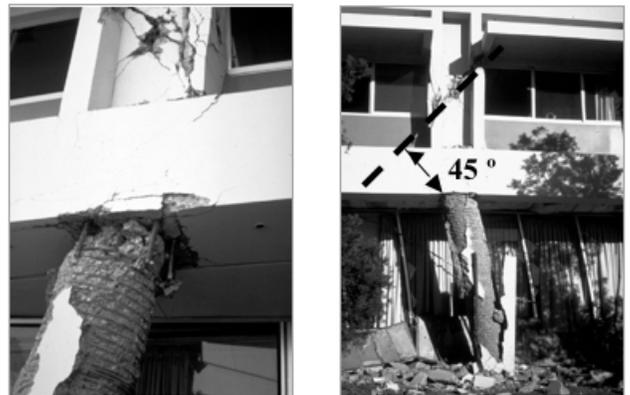
**Figura 30.** Problema de San Fernando California 1971. Transición de columna (Fuente: Bertero, 1971)
