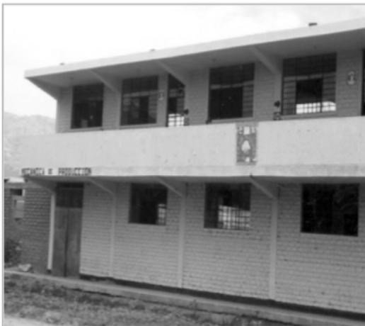
**Figura 14.** Confinamiento adecuado de columnas.
