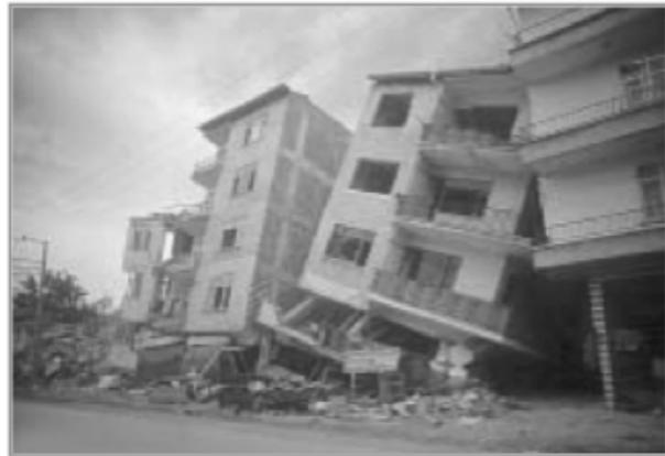
**Figura 17.** Desplazamiento lateral y ruptura de columnas
