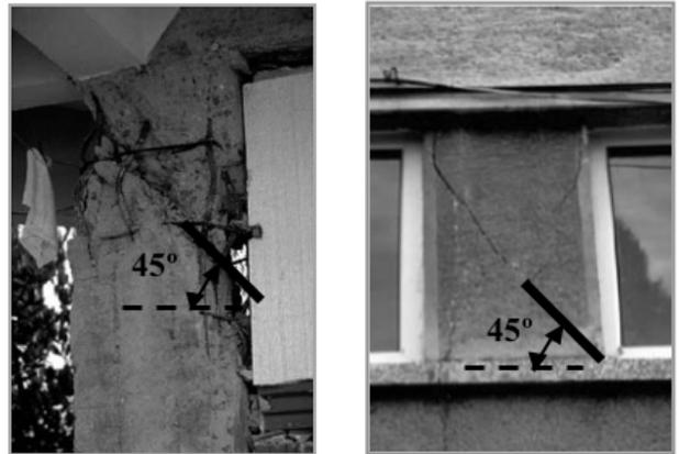
**Figura 12.** Falla frágil: Columna corta y poco refuerzo transversal
