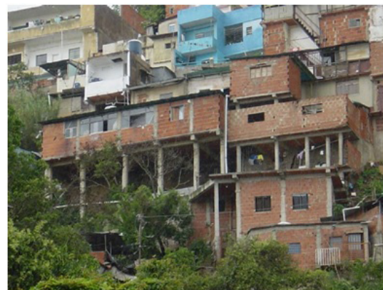
Figura 3. Construcciones populares en viviendas de Caracas incumplen las normas sismorresistentes
