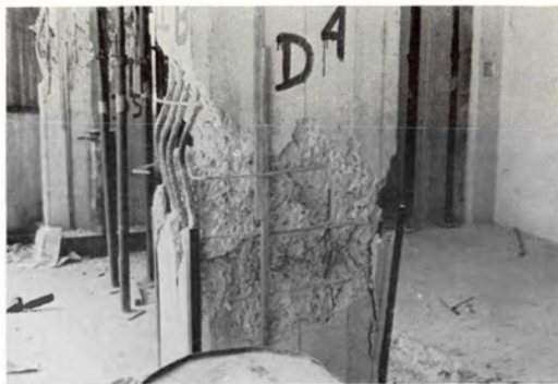
Figura 4. Detallado de columnas en edificios en Caracas afectados por el sismo de 1967: (a) Skinner, 1968; (b) Steinbrugge, 1967
