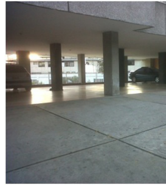
Figura 5. Edificios con carencia de planos resistentes bien definidos en una o dos direcciones horizontales
