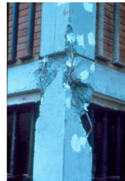
Figura 4. Detallado de columnas en edificios en Caracas afectados por el sismo de 1967: (a) Skinner, 1968; (b) Steinbrugge, 1967
