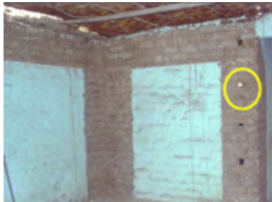
Figura 11. Perforaciones cada 0.50 m
