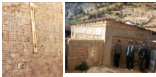
Figura 1. Malla electrosoldada, instalación y recubrimiento
