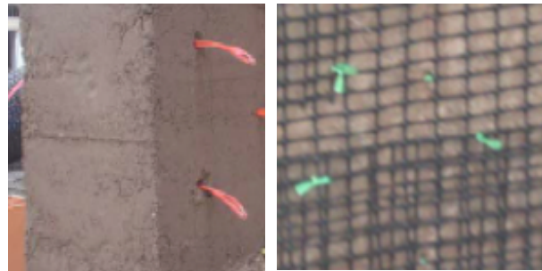
Figura 9. Conectores de paja rafia cada 0.25 m
