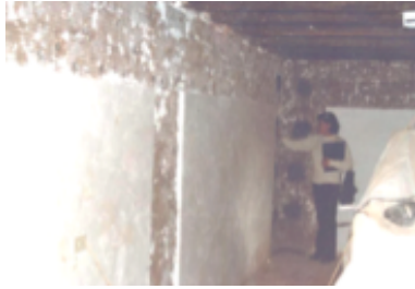
Figura 10. Eliminación del tarrajeo existente
