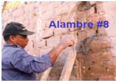
Figura 12. Instalación del conector y taponado de la perforación
