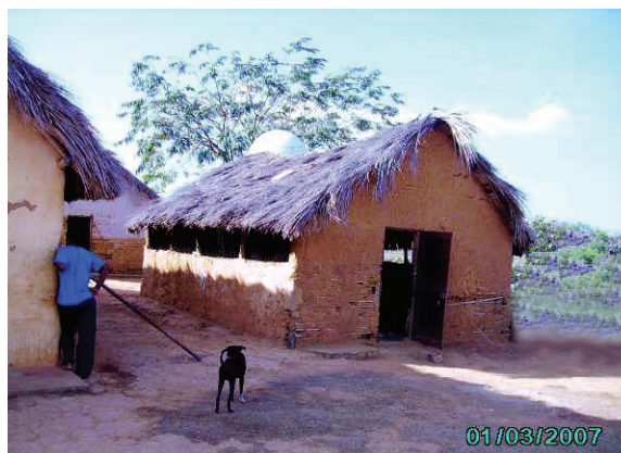
Figura 1. Casas de bahareque, mal frisadas, piso de tierra, techo de paja, perros libres en la comunidad E'ñepa, municipio Cedeño, estado Bolívar.
