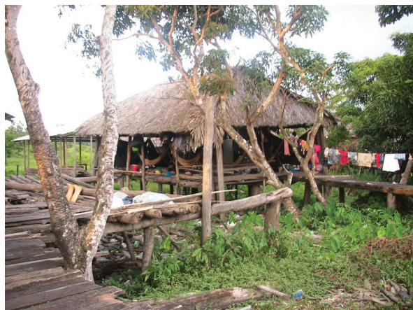
Figura 2. Casa de palafitos, sobre el río Orinoco (en época de sequía). Techo de paja, sin paredes. Comunidad Wuarao, municipio Antonio Díaz, estado Delta Amacuro.
